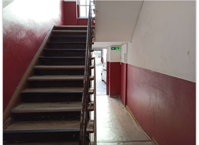
Treppenhaus ohne Aufzug
